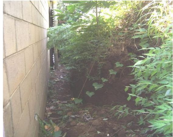
Fig. 13 Taludes inestables entre las Viviendas, provocando fragilidad de derrumbes principalmente en invierno
