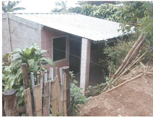
Fig. 5 Las casas se inundan por la inexistencia de canaletas de evacuación de aguas lluvias
