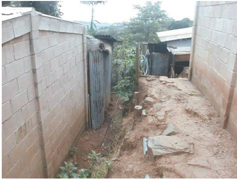
Fig. 8 No hay protección en las casas del Matazano para los taludes inestables
