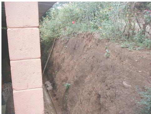
Fig. 6 No hay protección en las casas del Matazano para los taludes inestables
