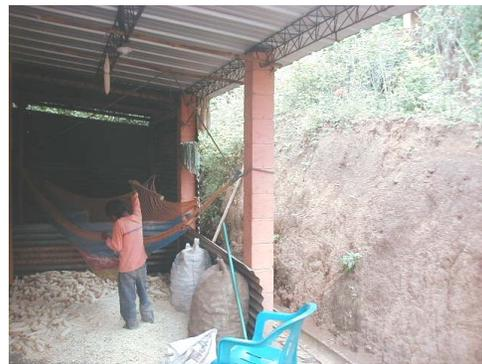
Fig. 7 No hay protección en las casas del Matazano para los taludes inestables
