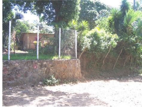
Fig.3 Protección en viviendas por las escorrentías superficiales
