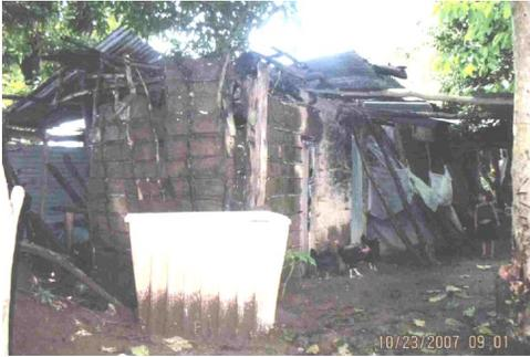
Fig. 2 Tipo de Vivienda en Tempisque, construida de plástico, bajareque y lamina, se encuentra en alto riesgo
