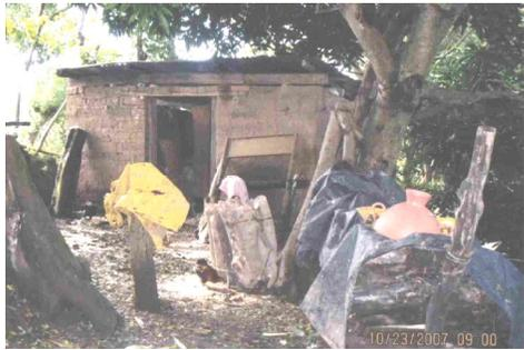
Fig. 10 Tipo de Vivienda, construida de Adobe, madera y lamina se encuentra en alto riesgo
