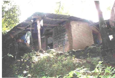
Fig. 3 Tipo de Vivienda en Tempisque, construida de Adobe, madera y lamina se encuentra en alto riesgo
