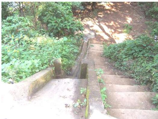
Fig. 14 Obras hidráulicas disipadoras de energía insuficientes en Santa Rita
