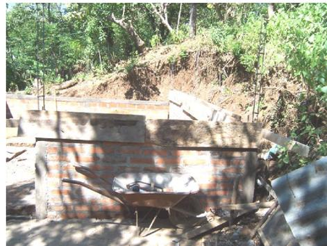
**Fig.3 Construcción de Vivienda en alto riesgo, problemas con taludes inestables**
