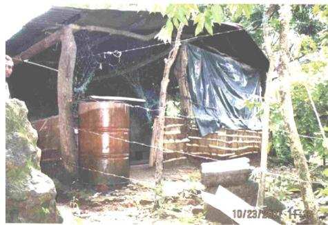
Fig. 7 Alto riesgo en Viviendas construidas de plástico y bambú
