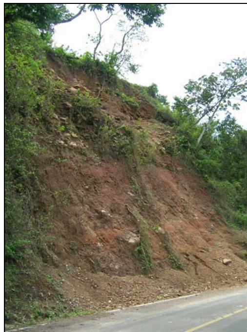
Foto 4. Carretera panorámica, cerca de San Francisco Chinameca.
