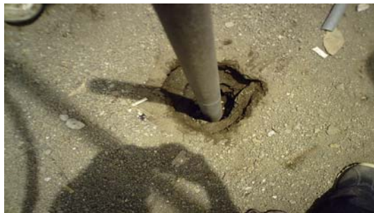
Figura 6.22. Problemas de derrumbe en SPT. Se observa como el material de la Unidad 2 se derrumba y cae en el agujero aumentando los valores de N medidos.
