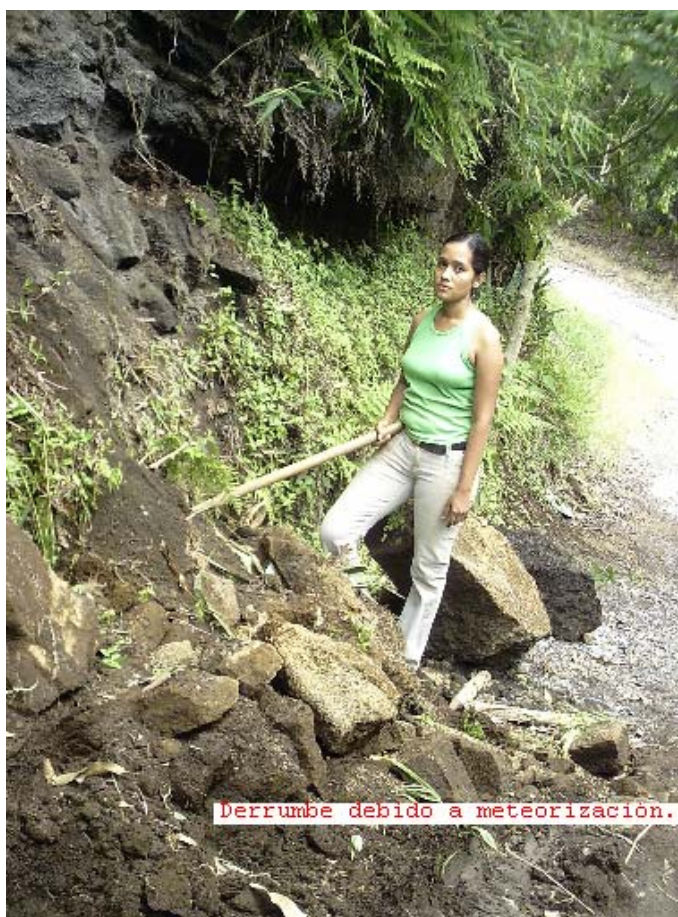
Figura 6.27. Derrumbe de la Unidad 3. Por efecto de las raíces de los árboles, por agrietamiento verticalizados, lluvias, sismos y por socavación al desprenderse el material suelto.
