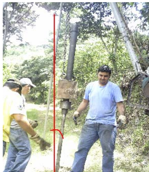
Figura 6.25. Inclinación de penetrómetro. Se observa los problemas de inclinación en las Pruebas de Penetración Estándar.
