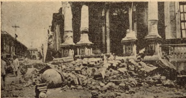
Fig. 10. Daños en la ciudad de San Salvador causados por los terremotos que acompañaron a la erupción de 1917.
