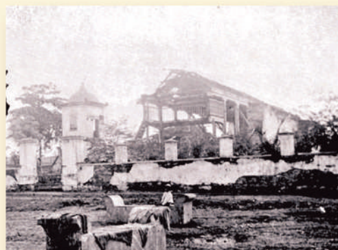
Iglesia de Quezaltepeque. Terremoto 1917
