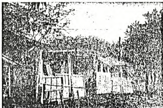
Foto 13. Finca «Los Naranjos»: establo de madera doblado en forma ondulatoria.
