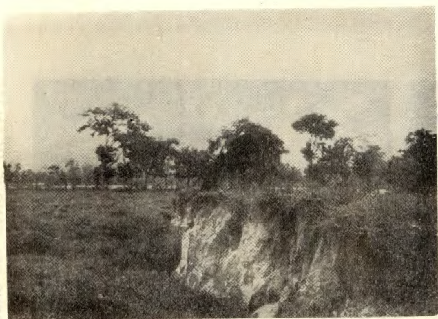
FIG. 31 FORMACION DE UNA ZANJA DEBIDA A FALLA DE LA COSTRA SUPERFICIAL
