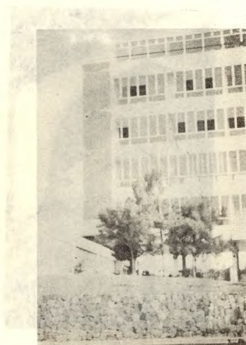
FIG.23 DAÑOS EN EL EDIFICIO G-6
