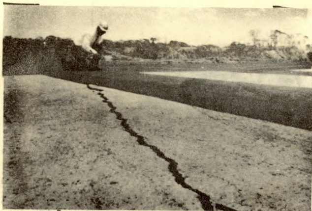
FIG.36 AGRIETAMIENTO DE LA PISTA DEL AEROPUERTO DE ILOPANGO
