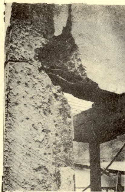
FIG. 29 FALLA POR DOBLADO Y ANCLAJE INADECUADOS DEL REFUERZO
