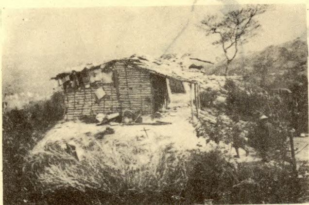
FIG.6 CONSTRUCCION TIPICA DE BAHAREQUE SIN REPELLADO
