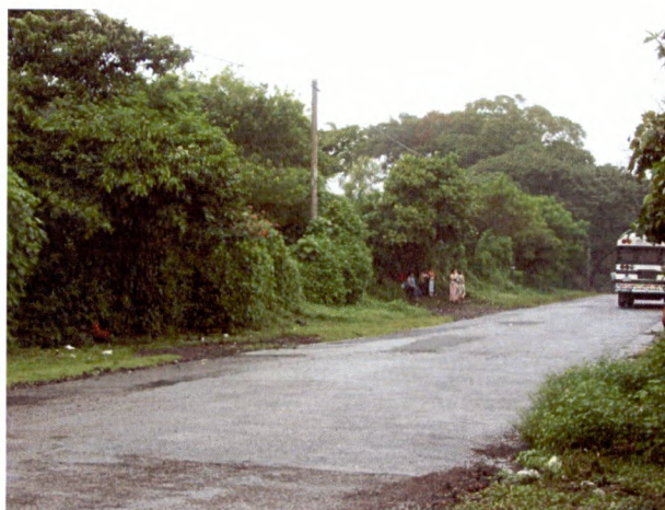
Se observa la calle expuesta a deslizamientos.
