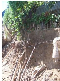
Fig. 7 Inestabilidad de taludes en viviendas Talud de alto riesgo al borde de la quebrada.
