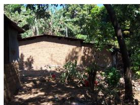
Fig. 15 Viviendas de Bloque de concreto donadas por AID, tienen peligro de derrumbes
