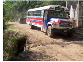
Fig. 5 Transporte colectivo en problemas de transitabilidad a causa del mal manejo de las aguas lluvias
