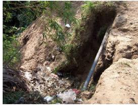
Fig. 3 Deterioro de calle principal y destrucción de cañerías de agua potable
