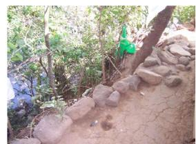
Fig. 17 Protección artesanal, para evitar la erosión del suelo
