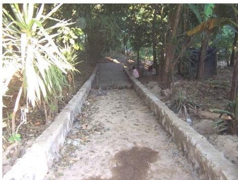
Fig. 10 Construcción de canaletas de manejo de aguas lluvias
