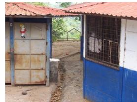
Fig. 9 Deterioro de andenes de escuela por la inadecuada evacuación de aguas lluvias
