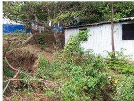
Fig. 11 Aulas de la escuela en peligro de derrumbe a causa del mal manejo de las aguas lluvias
