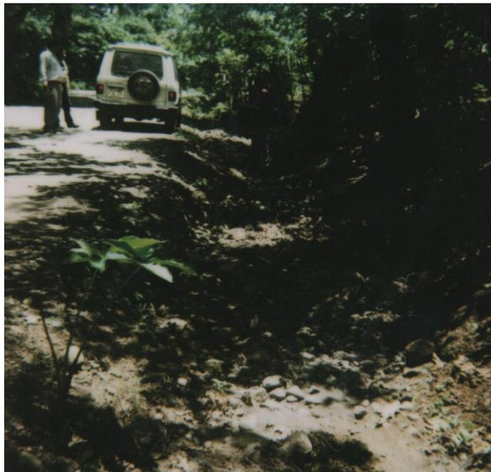
Fig.11: Zanjonamiento de la calle al volcán, maneja caudales hasta 6 m<sup>3</sup>/s.
