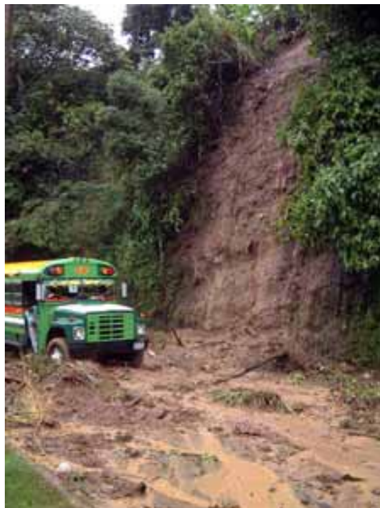
Derrumbe de tierra en el sector de La Cima, a causa de las fuertes lluvias. (Fuente: La Prensa Gráfica, oct. 2003)
