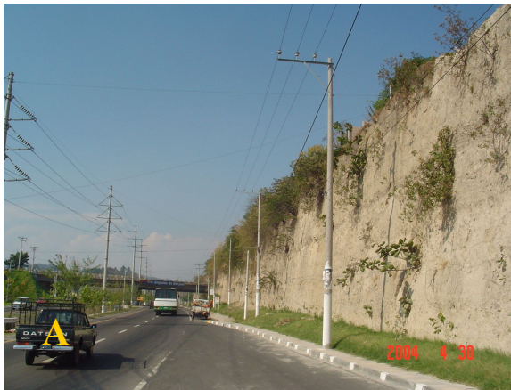
Figura 38. Taludes verticales en la Autopista San Salvador-San Miguel, frente a Unicentro Alta Vista. A) Talud inferior de unos 8 m de altura en Ignimbrita F. B) Talud completo de unos 12 m de altura separados por una berma angosta con la porción superior compuesta por la Unidad G.
