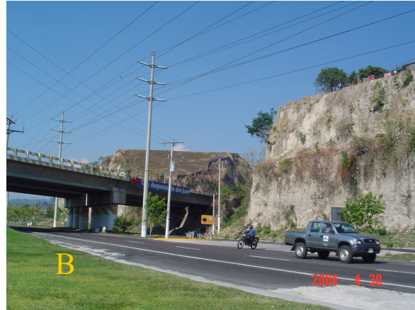
Figura 38. Taludes verticales en la Autopista San Salvador-San Miguel, frente a Unicentro Alta Vista. A) Talud inferior de unos 8 m de altura en Ignimbrita F. B) Talud completo de unos 12 m de altura separados por una berma angosta con la porción superior compuesta por la Unidad G.
