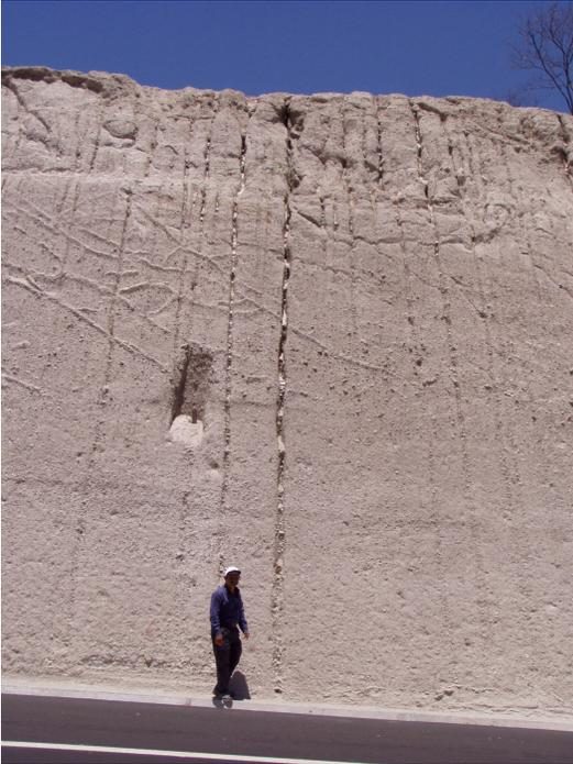
Figura 40. Formación de surcos de erosión en taludes de ignimbritas (Unidad F) de la Tierra Blanca Joven.
