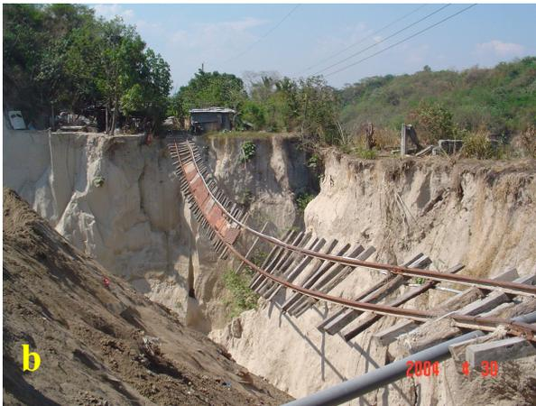
Figura 44. Derrumbe en la Comunidad 3 de Enero. a) vista de la parte colapsada con tubo de vertidos residuales en nivel bastante superior al fondo del derrumbe. La bóveda está soterrada. b) comunicación perdida entre la comunidad por la caída del talud y destrucción de la línea férrea.
