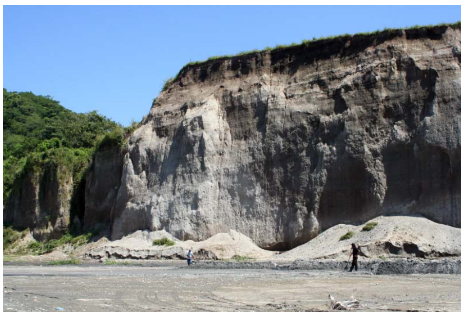
Foto No. 25 Derrumbe por la erosión lateral del Río Las Cañas cerca de la Finca San Joaquín.
