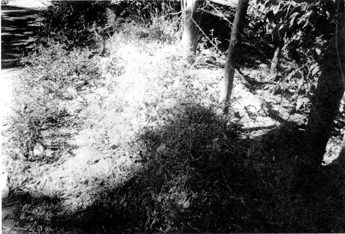
**Fotografía 15. Bordo en el límite lateral de la vía rural, que evita la erosión en los terrenos inmediatos debido al escurrimiento superficial en la vía.**
