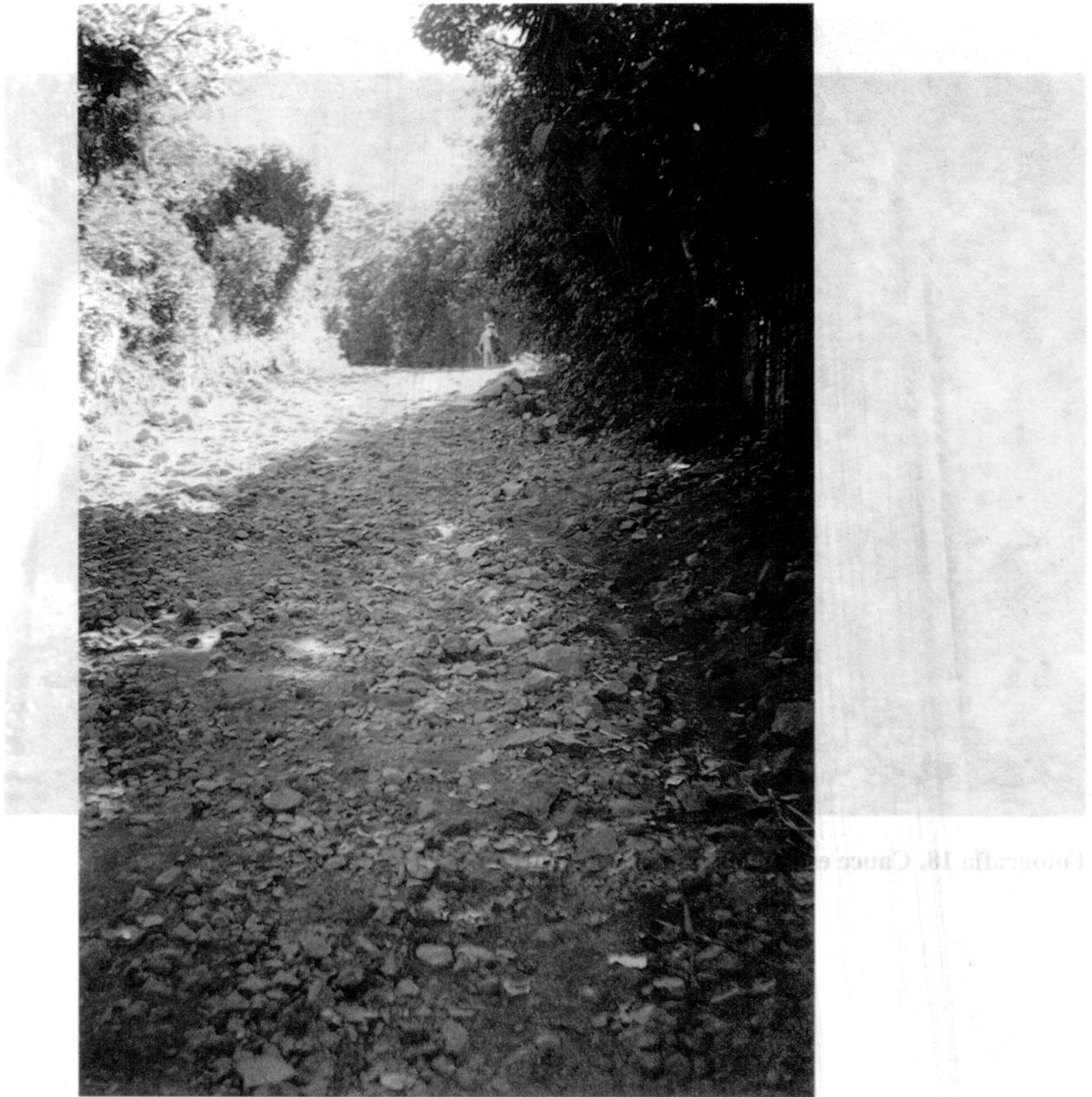
**Fotografía 17. Calle rural con piedra que reduce la erosión en la vía y la velocidad de escurrimiento superficial.**
