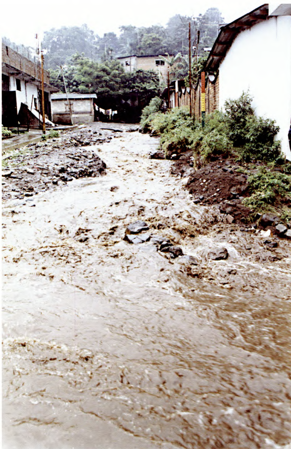
Fotografía 10. Imagen que ilustra el problema de las avenidas provenientes del cerro Pelón, y que afectan, tal como se observa, el pasaje Atlacatl, un sector crítico de la ciudad de Berlín.
