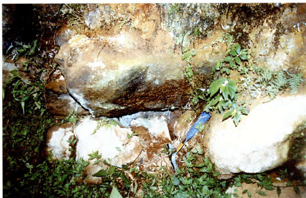
Fotografía 4. Fracturamiento en las juntas de enfriamiento de las lavas.
