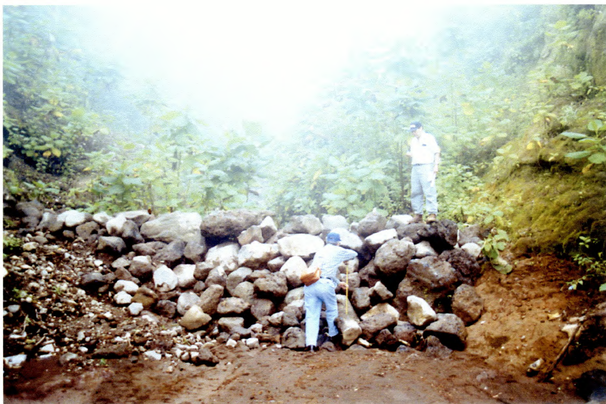
Fotografía 9. Ilustración de una estructura tipo Enrocado, construida en la Colonia El Jardín, a la altura del caserío San José. Este tipo de estructura es funcional en el área siempre y cuando se aproveche la piedra suelta del cauce.
