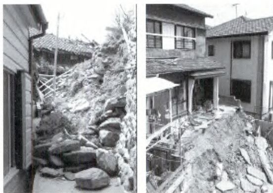
Figura 8b Daños en casas tradicionales causados por el terremoto de Fukuoka en 2005.
