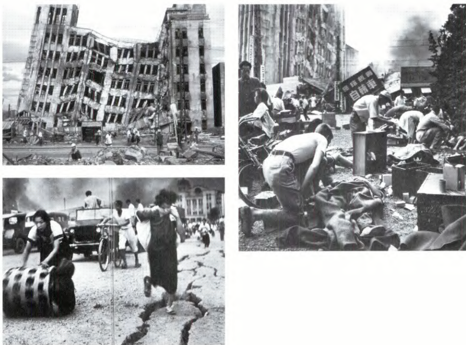
Figura 4. Terremoto de la ciudad de Fukui, 1948. La ciudad fue completamente destruida.
