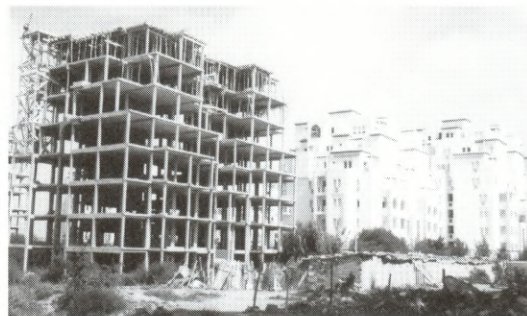
Edificio en construcción a base de concreto armado
