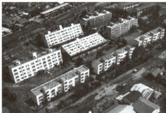
Figura 5. Terremoto de Niigata de 1964. Volcamiento de estructuras de concreto armado y falla en puentes debido a la licuefacción del suelo.
