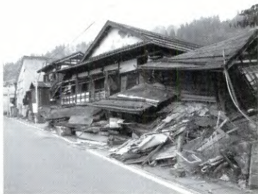
Figura 8a. Daños en las ciudades de Kawaguchi durante el terremoto de Niigata en 2004.
