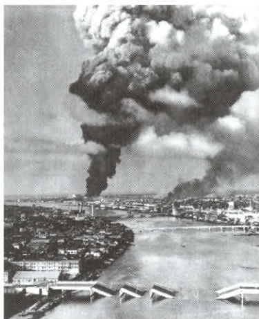
Figura 5. Terremoto de Niigata de 1964. Volcamiento de estructuras de concreto armado y falla en puentes debido a la licuefacción del suelo.
