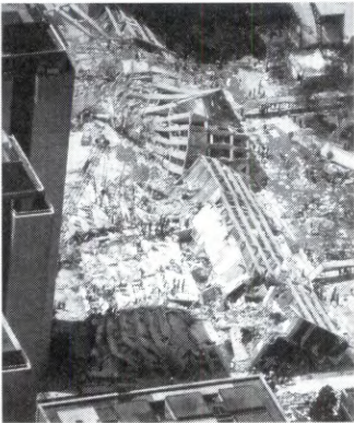
Figura 13a. Edificio colapsado y dañado en la ciudad de México.
