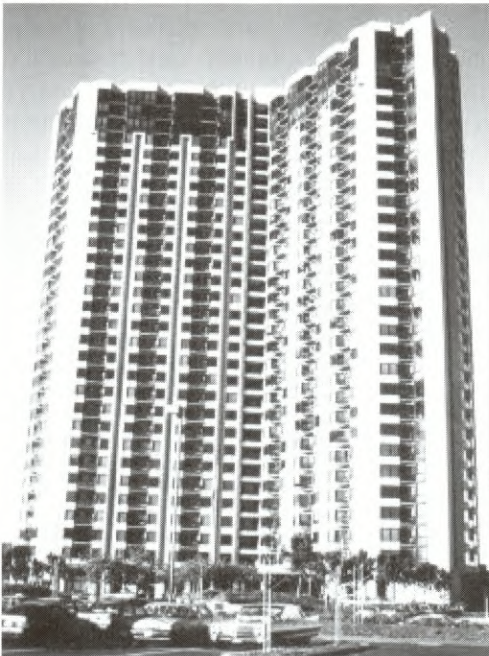
Figura 14a. Zona urbana de San Francisco. Se trata de ejemplificar las condiciones reales del suelo que no son apreciadas, cuando ya existen urbanizaciones.
