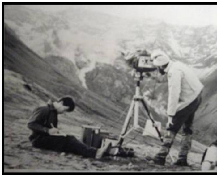
Fotografía 10. Medición con EDM, USGS, 1980.
