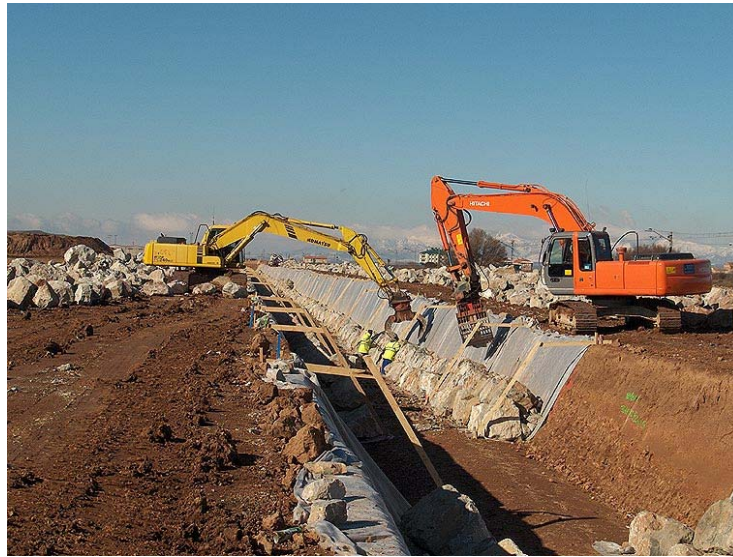
Figura 5.32. Procesos constructivos de escolleras.
