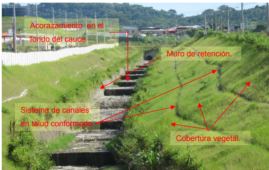
Figura 5.29. Sistema de canalización en Residencial los Almendros [Julio, 2009]
