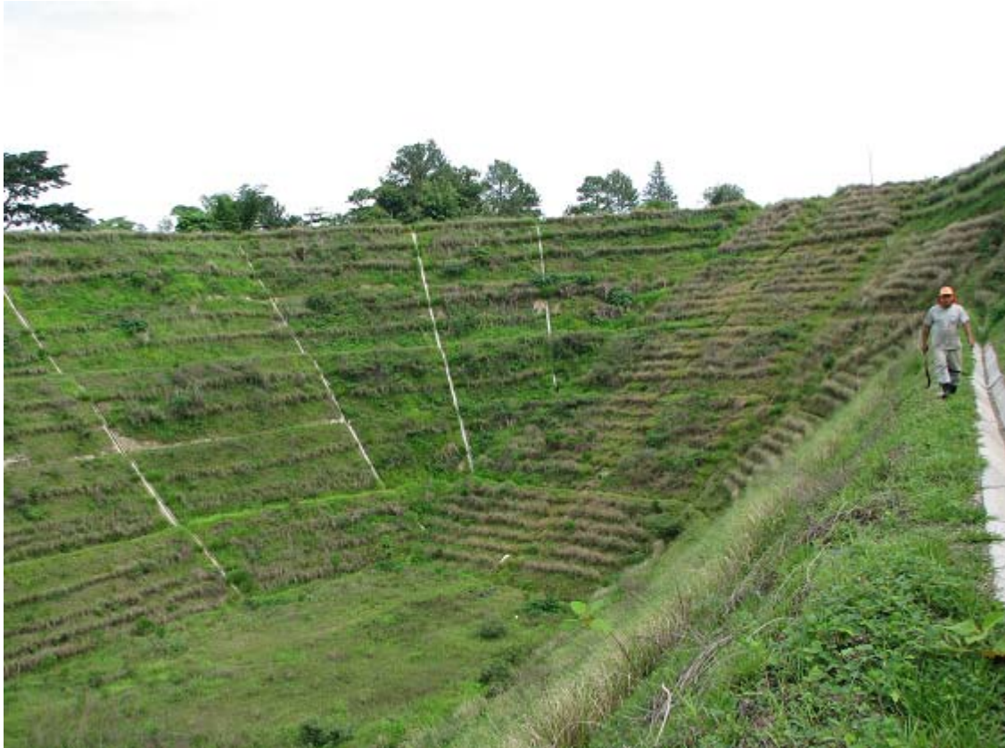
Figura 5.21. Fotografía de punto de muestreo 5 en el cual se puede ver el sistema de taludes en forma de terrazas y sus sistemas de drenajes [Junio, 2009].
