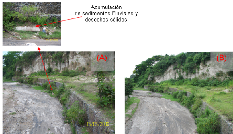
Figura 5.18. Fotografía: (A) muestra las condiciones iniciales del punto de monitoreo 3 en la Qda. Arenal Seco antes de las primeras precipitaciones [Mayo 2009], (B) muestra punto de monitoreo 3 después de la primeras precipitación, en donde se puede ver el aumento de la vegetación y la disminución de los sedimentos fluviales y desechos sólidos en la base de los gaviones [Junio, 2009].
