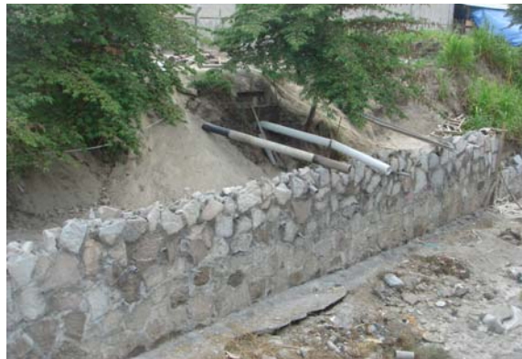
Figura 5.23. Obra de protección longitudinal hecha por un muro de gravedad en el cauce de la Qda. Arenal Seco, en la zona franca, San Bartolo. [Mayo 2009].
