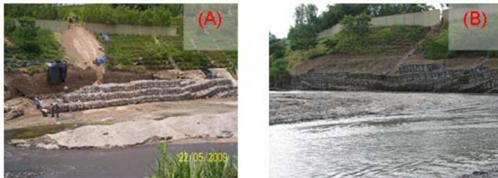
Figura 5.20. Fotografía: (A) muestra el proceso de reconstrucción del los gaviones [22 mayo 2009], (B) presenta los asentamientos diferenciales en toda la base del muro de gaviones luego de haber finalizado los trabajos de reconstrucción. [Junio, 2009].
