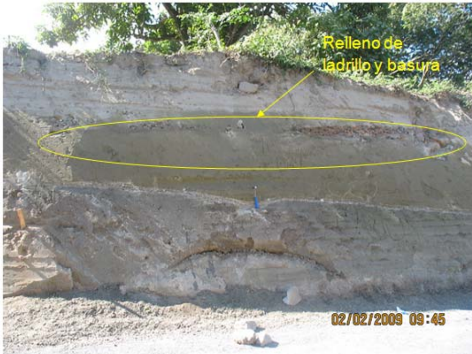
Figura 3.28. Fotografía mostrando material retrabajado en un talud ubicado en la calle a Huizucar [Febrero, 2009].
