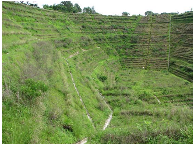
Figura 5.40. Sistema de taludes en forma de terraza escalonada, recubrimiento de vegetación, vetiver y con su sistema de drenaje, con una altura aproximada de 60 m, punto de monitoreo 5 [Junio, 2009].
