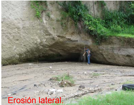
Figura 5.2. Erosión lateral en el río Las Cañas [Julio, 2009]
