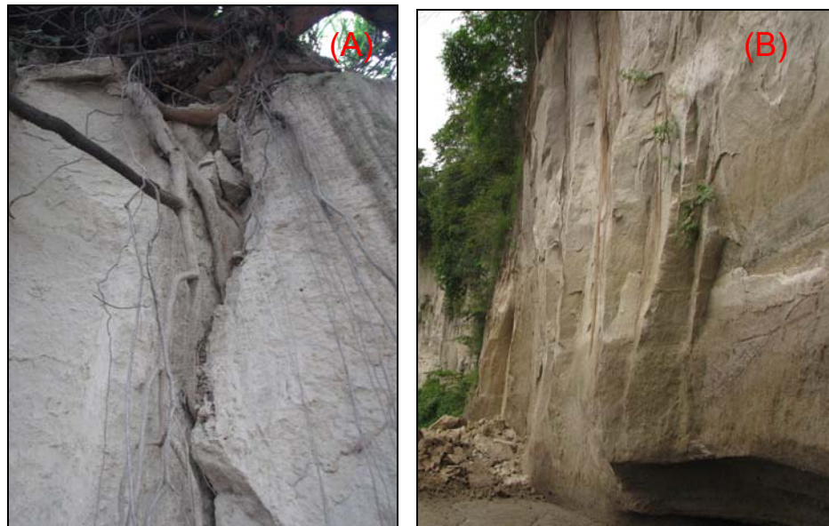
Figura 5.9. Mecanismo de ruptura en TBJ, (A) talud en intersección Av. Los Sisimiles y 33 Av. norte, San Salvador. (B) talud en río Las Cañas. [Julio, 2009]
