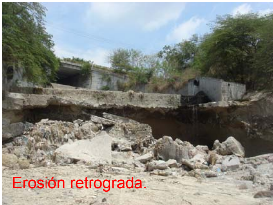
Figura 5.4. Erosión retrograda en Qda. Arenal Seco [Julio, 2009]
