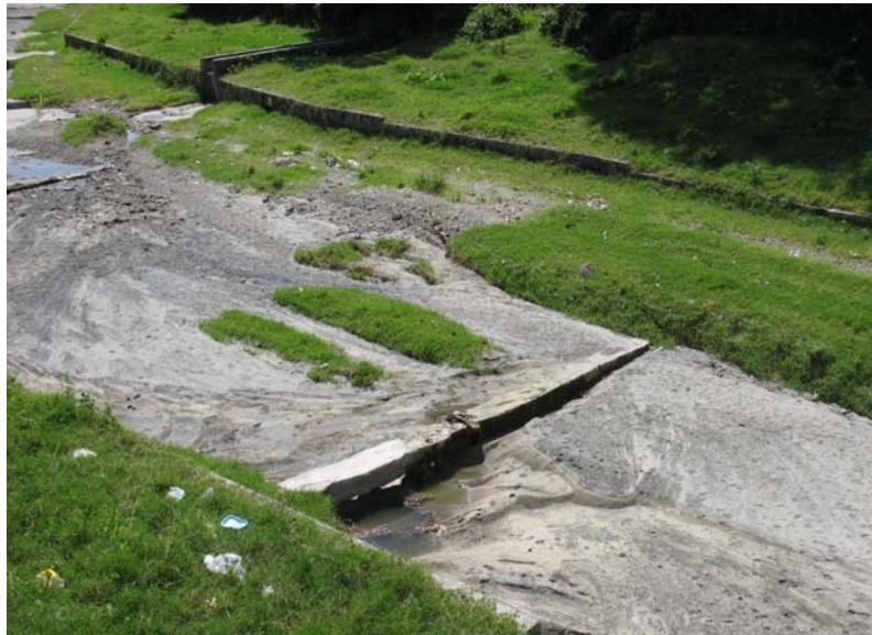
Figura 5.30. Obra transversal en cauce de la Qda. Arenal Seco con problemas de socavación [Mayo, 2009].
