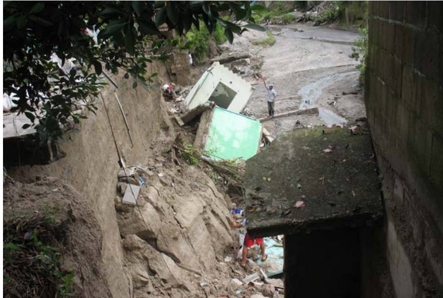
Figura 5.13. Colapso de vivienda ubicada Urbanización Nuevos Horizontes en las orillas de la Qda. Arenal Seco [Agosto, 2009].
