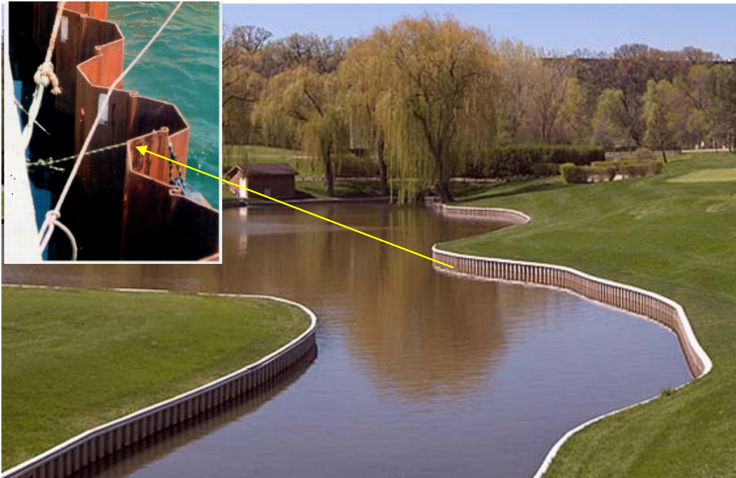
Figura 5.38. Canalización de río por medio de tablaestacas.
