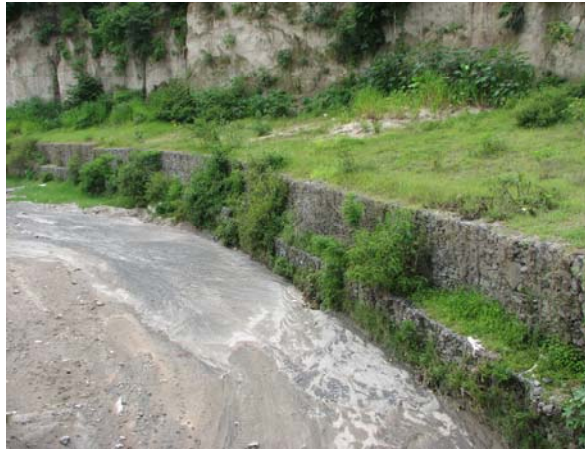
Figura 5.31. Muro de gaviones en el cauce del Arenal Seco, en la urbanización Nuevos Horizontes, Ilopango. (Junio 2009).
