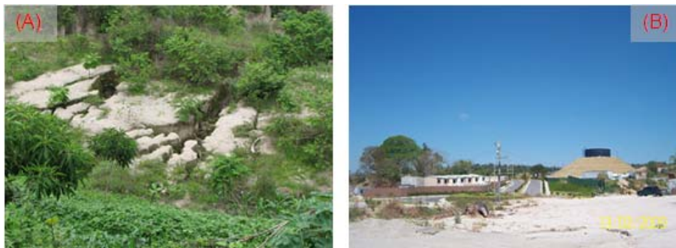
Figura 3.30: (A) ausencia de la unidad "G" por proceso de erosión, (B) ausencia de unidad "G" en la urbanización Los Almendros en San Martín a causa de la terracería [Marzo, 2009].
