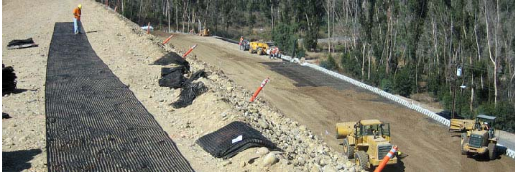
Figura 5.36. Reforzamiento de un talud con geomallas.
