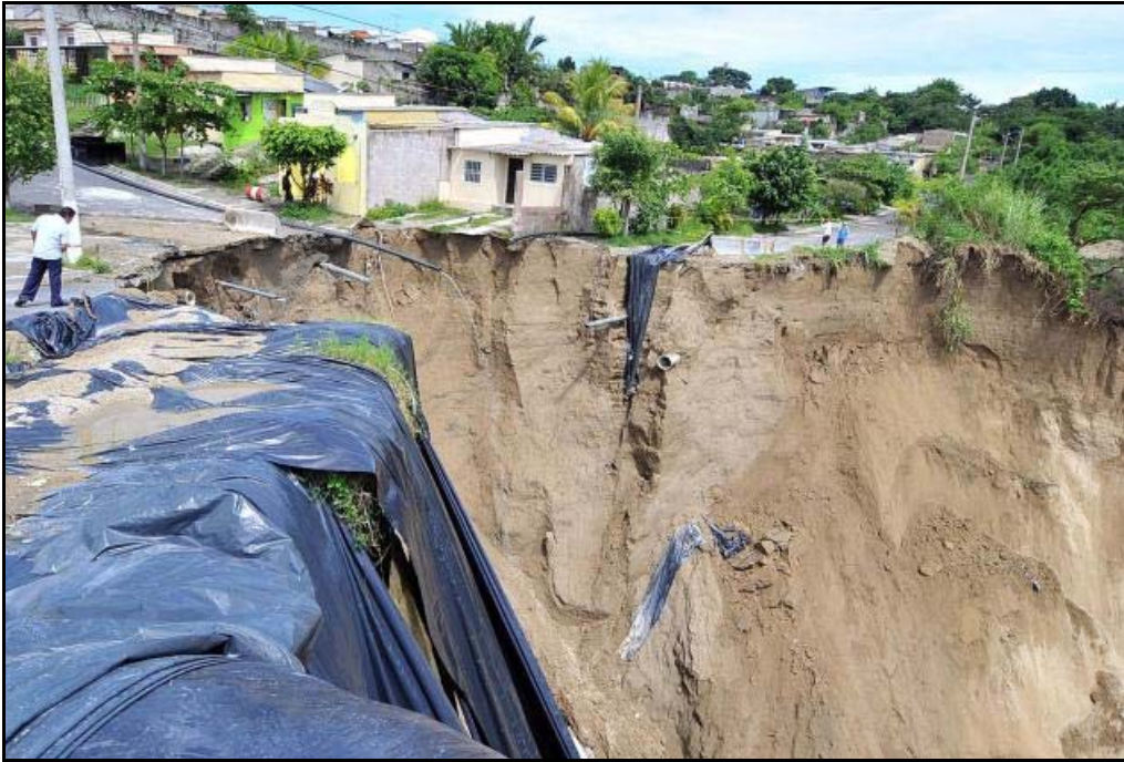
Figura 5.7. Cárcava de colonia Santa Lucia en el municipio de Llopango, mostrando el colapso del suelo y la ruptura de las tuberías [2009].
