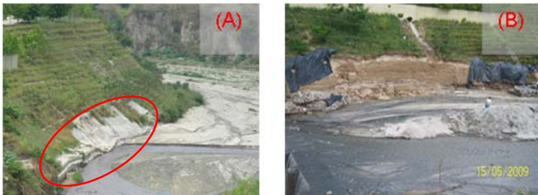
Figura 5.19. Fotografía: (A) muestra las condiciones iniciales del punto de monitoreo 4 en el río de Las Cañas antes de la primera lluvia [8 mayo 2009], (B) muestra punto de monitoreo 4 después de la primera precipitación, en donde se puede ver que los gaviones fueron arrastrados y la erosión lateral del talud [15 mayo, 2009].
