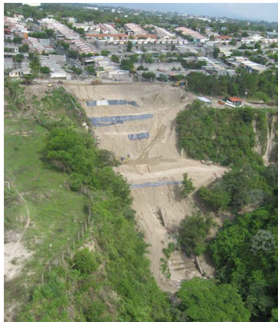
Figura 5.39. Vista aérea de la obra de protección en cárcava, ubicada en colonia Santa Lucia, Ilopango. [Mayo, 2009]
