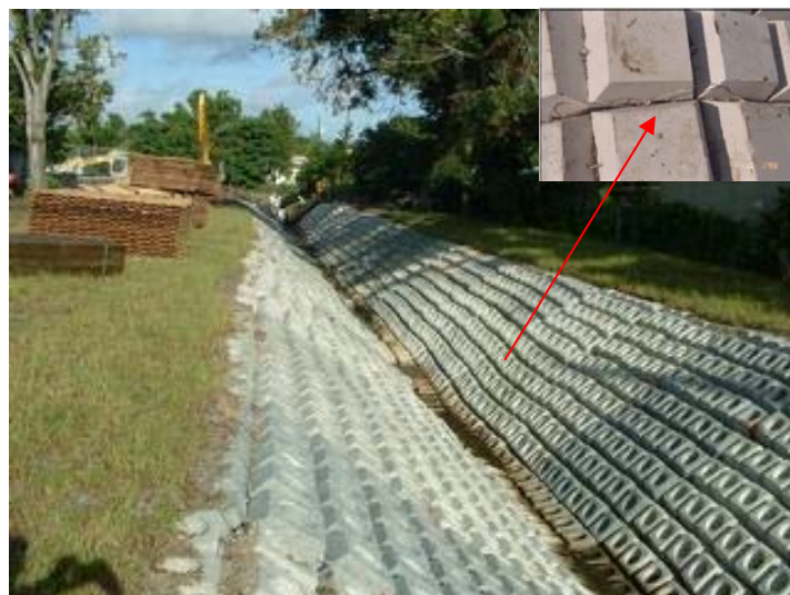
Figura 5.37. Canal revestido de sistema cable concreto.
