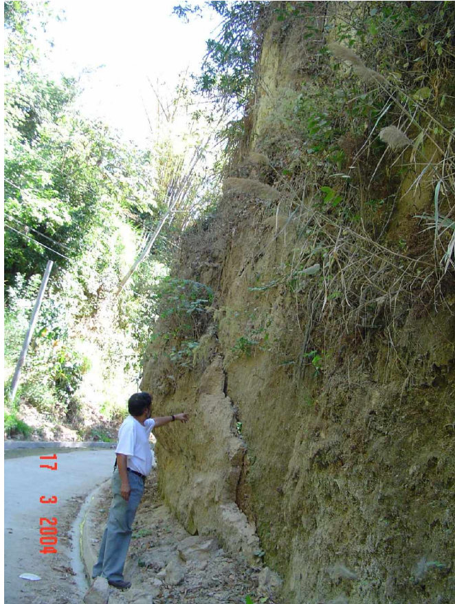
Figura 8. 4 Vista de fallas planas que ocurren paralelas a la cara del talud de la col. Brisas del Sur.
