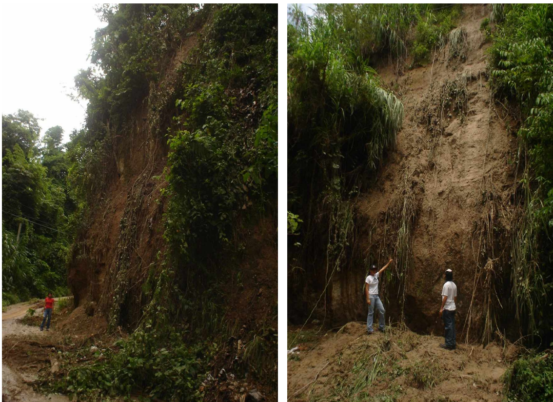
Figura 1. 2 Deslizamientos superficiales ocurridos en el talud de la col. Brisas del Sur el 3 de Julio de 2005 debido a las precipitaciones.
