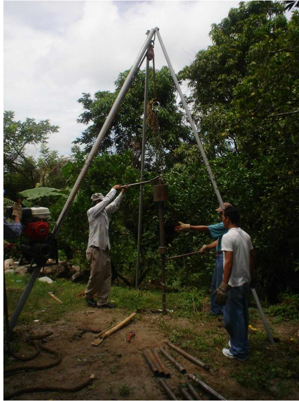
Figura 4. 4 Ensayo SPT en el talud de la col. Brisas del Sur.
