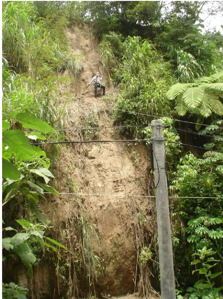
Figura 2. 12 Maniobras efectuadas para la medición de espesores en las unidades.
