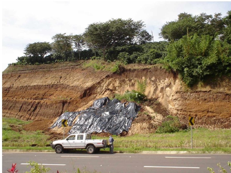
Figura 8. 12 Mecanismo de falla circular en cenizas volcánicas disparado por lluvias [Hernández, 2005].
