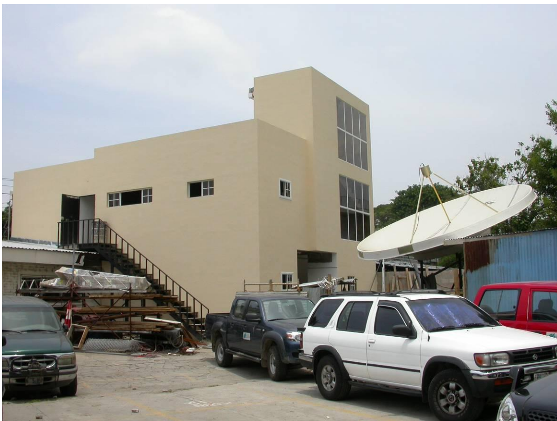
Figura 14: Laboratorio de calidad de agua en construcción
